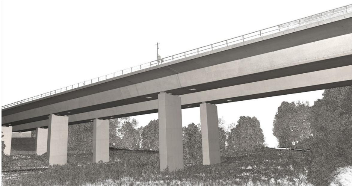
Abb. 1: Punktwolke einer gescannten Autobahnbrücke an der Autobahn A7 / Deutschland
