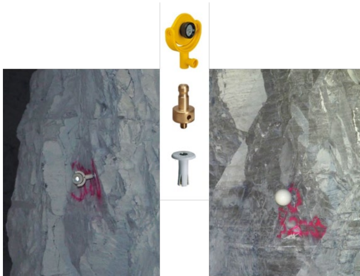
Abb. 4: Anbringen von Gewindeaufnahmen (Dübelbolzen) für Steckzapfen
