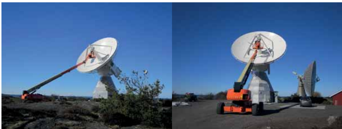
Abb. 2: Einsatz eines Krans zur Montage und Ausrichtung der Paneele
