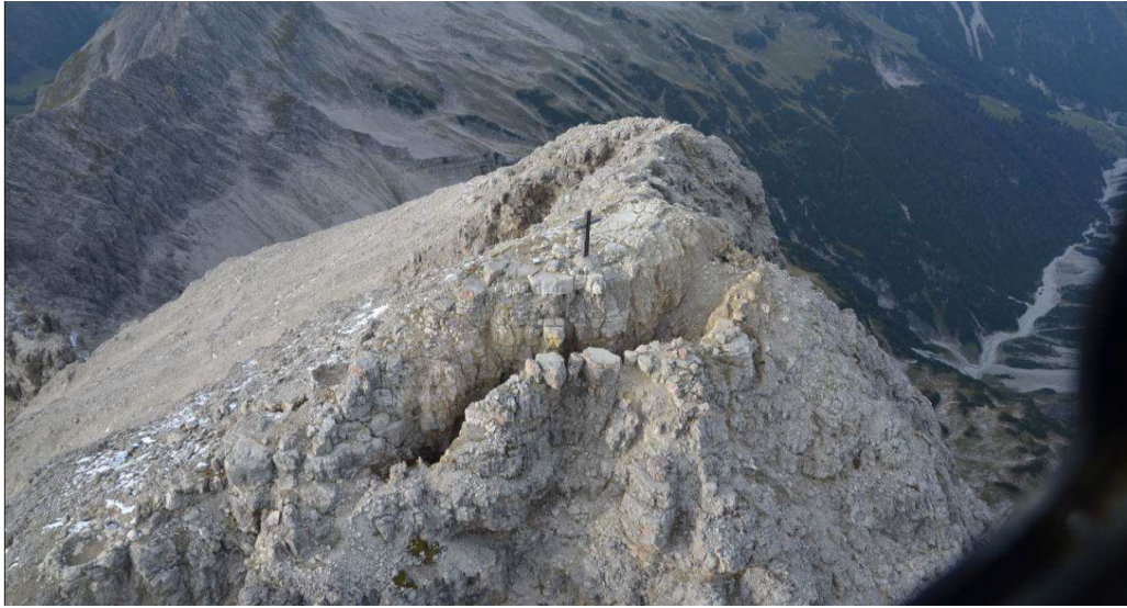
Abb. 1: Gipfelbereich des Hochvogel mit markanter von Nordosten nach Südwesten verlaufenden Spalte (Foto von HEIBEL & FIGL 2014)
