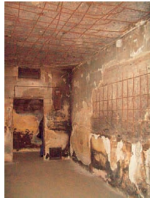
Abb. 51: Einer der Bunkerräume in den Tiefgeschossen des Flughafengebäudes in Berlin-Tempelhof, in denen im Mai 1945 die Akten der Gesellschaft verloren gingen. Aufgenommen im Jahre 2007.
