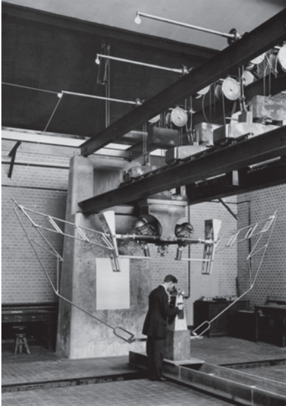
Abb. 31: Der Triangulator nach BOYKOW in den Räumen der N. V. Aerogeodetic in Berlin-Zehlendorf im Jahre 1926.
