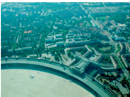
Abb. 50: Der Gebäudekomplex des Berliner Flughafens Tempelhof (etwa im Jahre 2000). Die Räume der Hansa Luftbild GmbH und damit auch die Geschäftsstelle der Deutschen Gesellschaft für Photogrammetrie befanden sich im Nordflügel am Columbiadamm (im Bild rechts).
