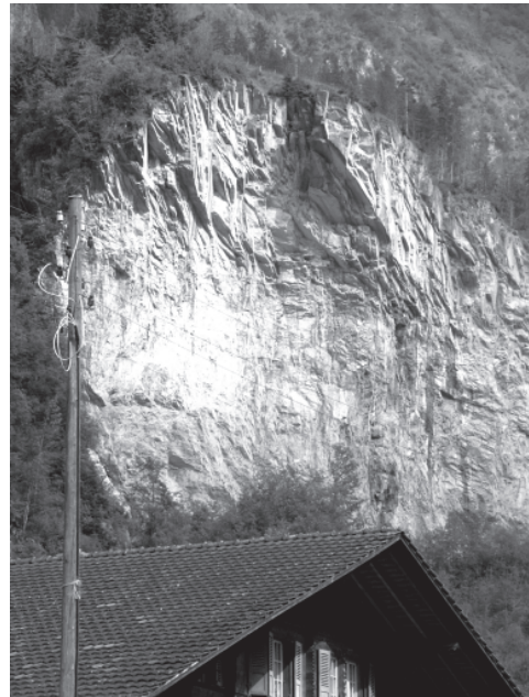
Abb. 1: Felswand mit Überhang im Rhonetal (Schweiz). Das Haus im Vordergrund ist durch Felsstürze aus der Wand gefährdet.
