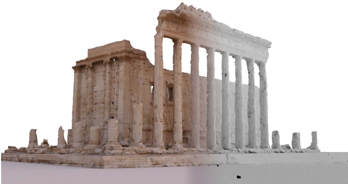
Abb. 10: Das definitive 3D-Modell des Baaltempels als trianguliertes Oberflächenmodell der fusionierten Punktvolke (rechts) und Modell mit Texturen aus den Inputbilddaten (links)
