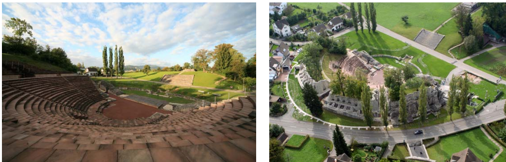
Abb. 1: Das restaurierte Theater von Augusta Raurica (AUGUSTA RAURICA 2016)
