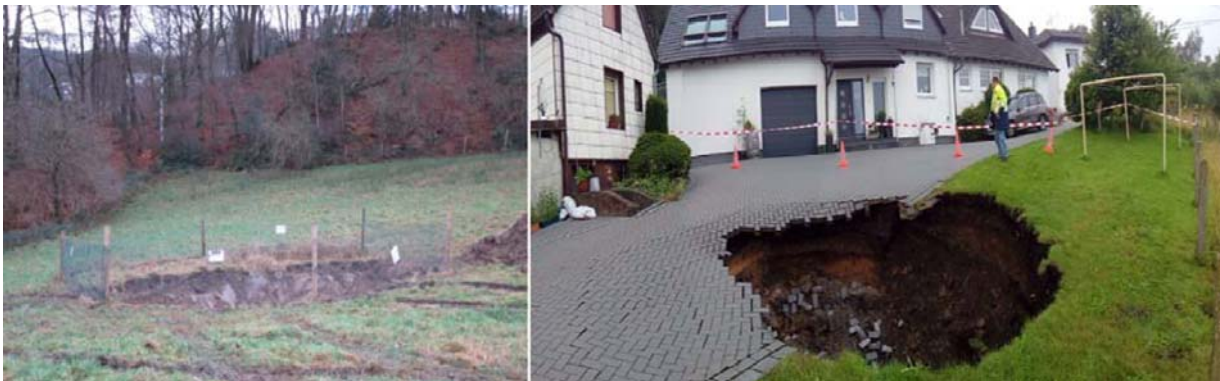
Abb. 1: Tagesbruch auf einer Weide (links) und einer Hauszufahrt (rechts)
