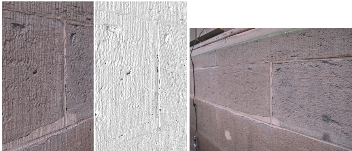
Abb. 8: Fassade der HFT, links 3D-Model texturiert, Mitte 3D-Model ohne Textur, rechts Farbbild des Datensatzes
