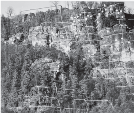
Abb. 8: Elbseitige Ansicht des Basteimassivs in der Sächsischen Schweiz, Messbild mit Markierung der vermessenen Klüfte, Profil- und Höhenlinien.
